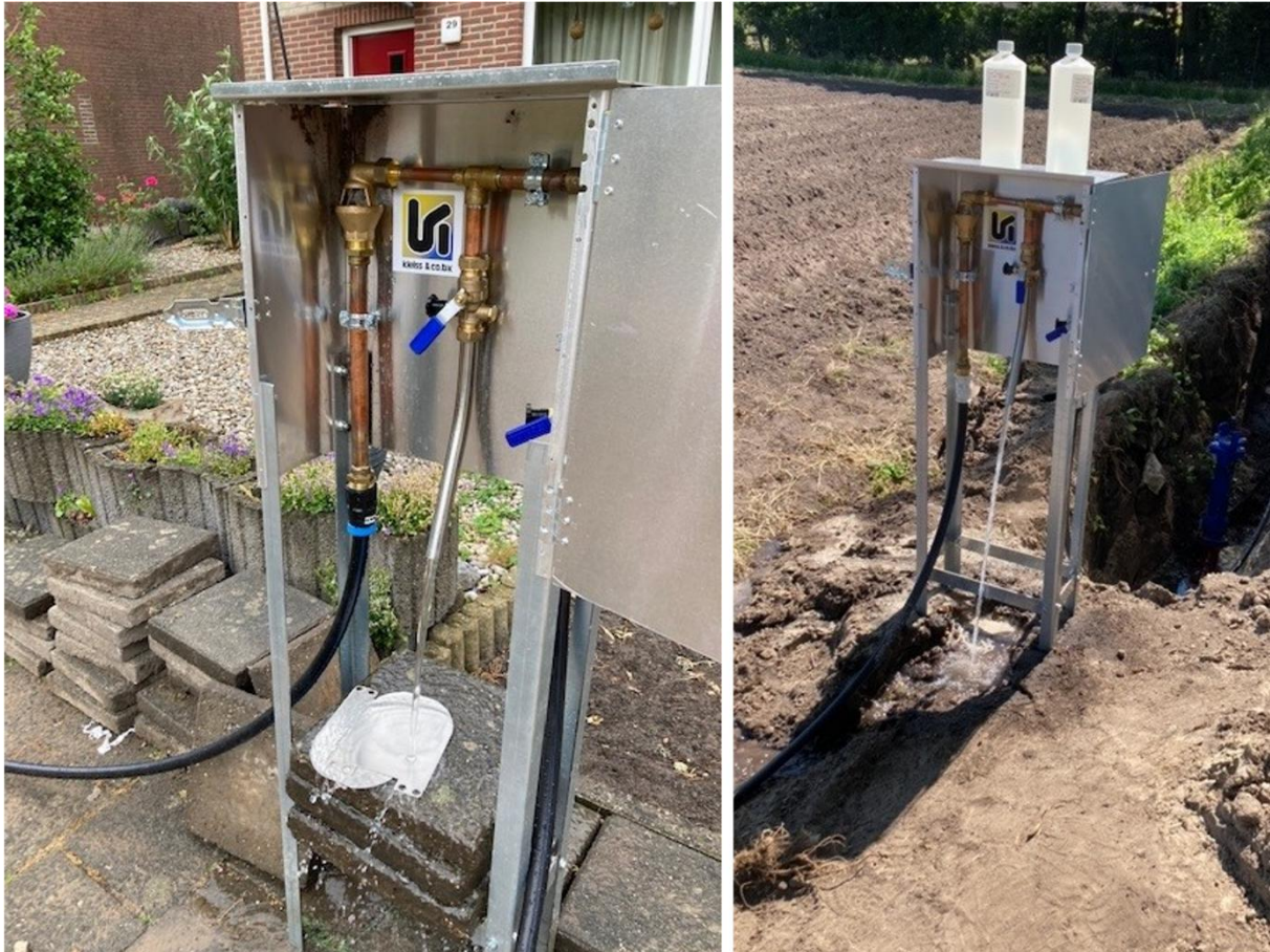
Afbeelding 2. Monstername met een monsterkast gedurende 48 uur na de werkzaamheden
